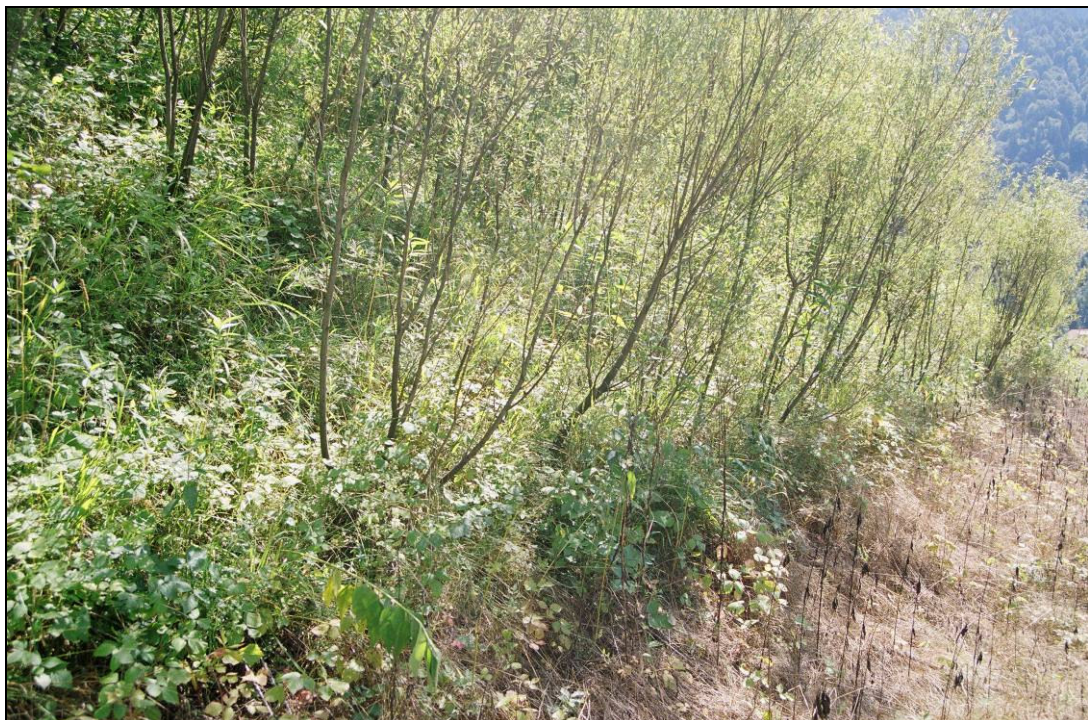
Rio Bianco, Santa Caterina, agosto 2006. Rigoglioso sviluppo delle talee di salice delle gradonate sulla scarpata.
