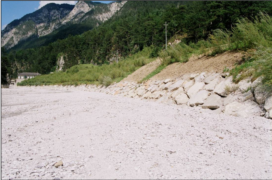
Rio Bianco, Santa Caterina, agosto 2006. Si nota sulla destra, l'intervento di ripristino sponda a seguito dell'evento alluvionale dell'agosto 2003.
