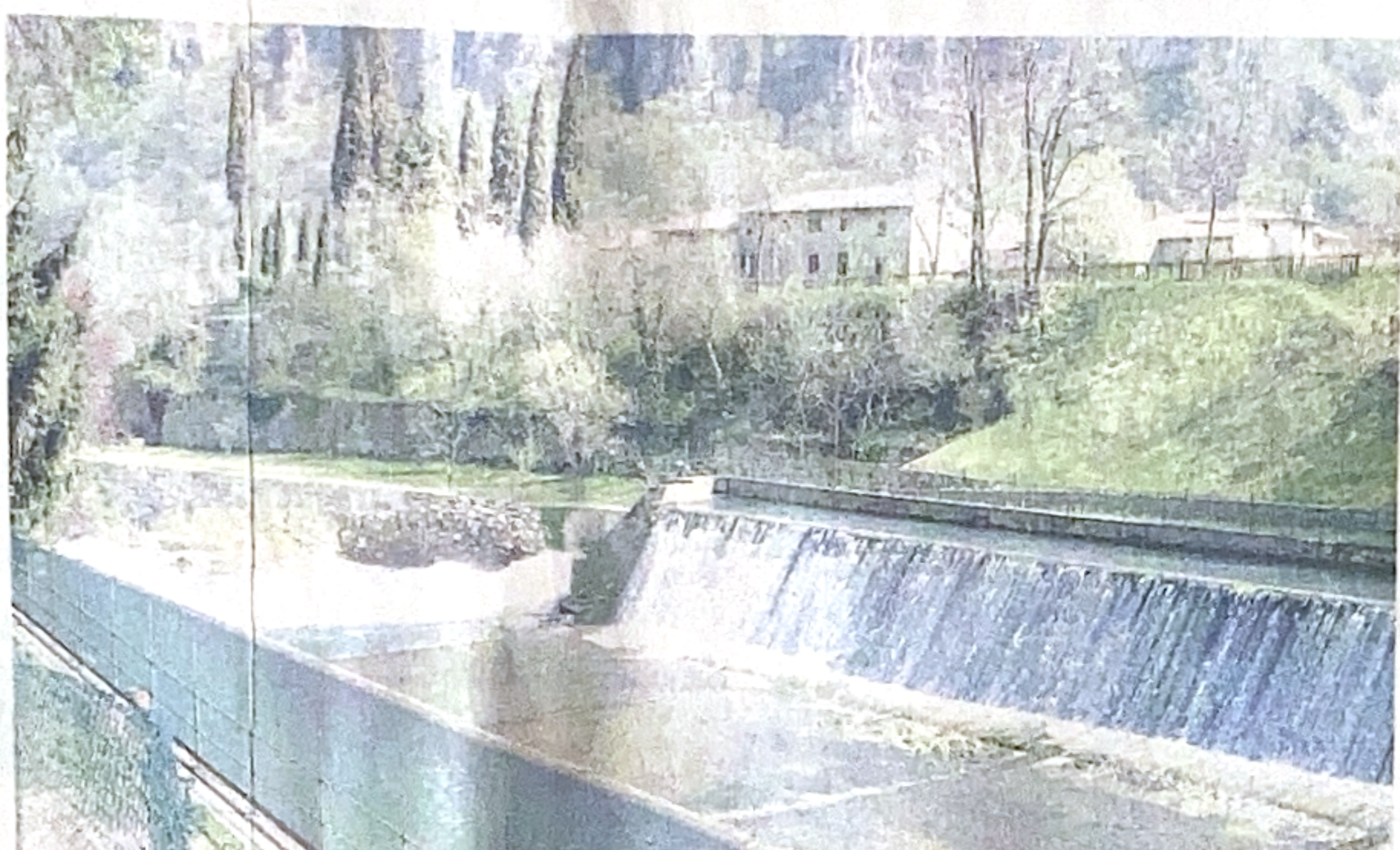
Nel vicentino. La centrale idrica di Ollero, la più importante di Etra, che attinge dal sistema carsico dell'Altopiano di Asiago
